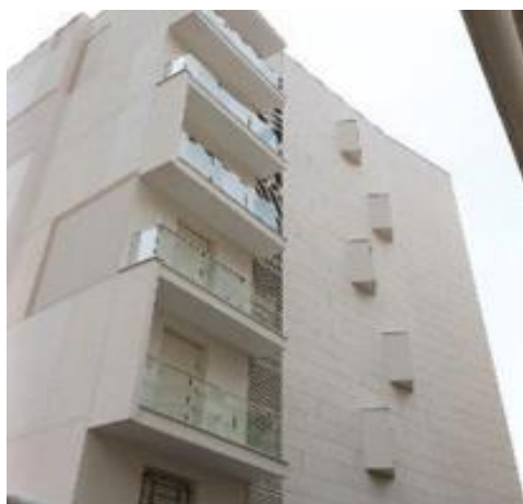
Une intégration sur-mesure
