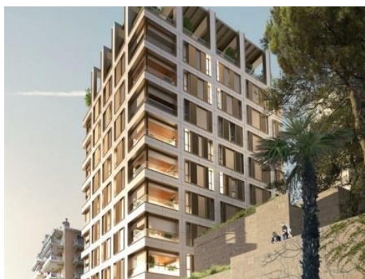
Une tour en bois (planchers, murs, toiture)
