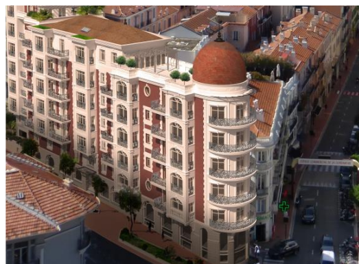
Un bâtiment traversant
